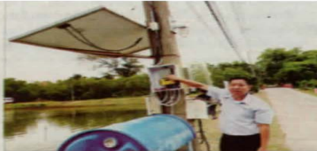
ชุดควบคุม
